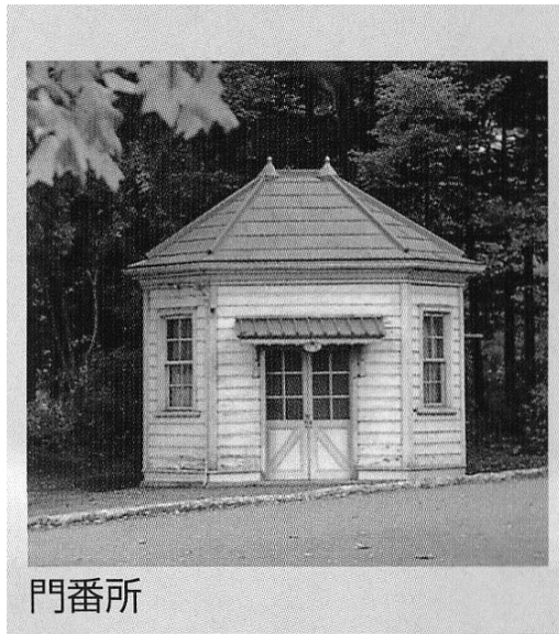
重要文化財「旧盛岡高等農林学校本館 門番所」
